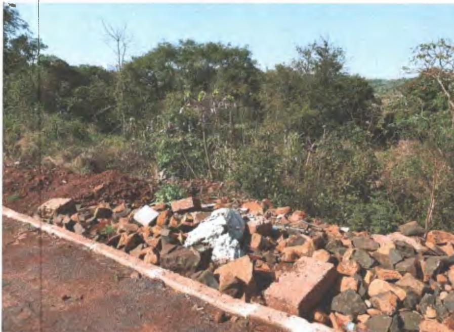
Foto 08 – Contenção inexistente e resíduos de obra por toda via
