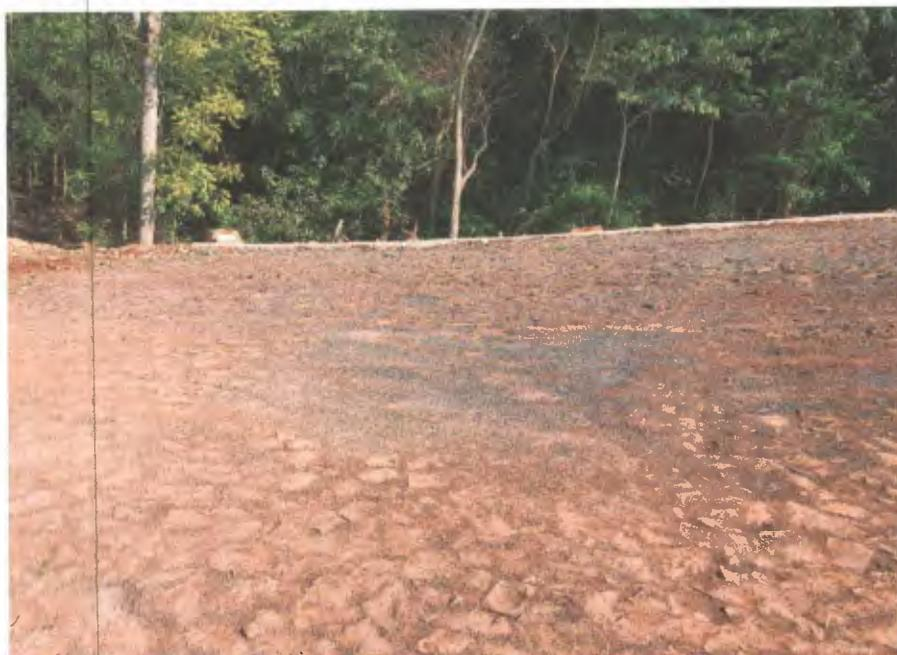
Foto 06 – Rejunte de pó de pedra insuficiente e incorreta execução
