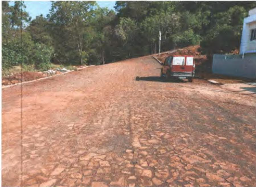
Foto 11 – Rejunte de pó de pedra insuficiente e incorreta execução
