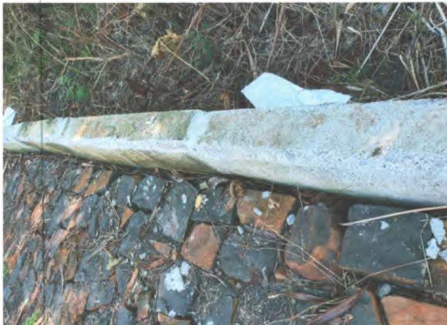
Foto 48 – Meio-fio cortado com aparentemente com serra circular elétrica
