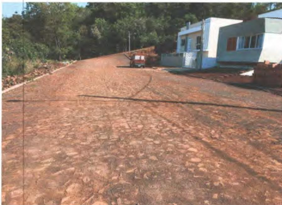
Foto 13 – Rejunte de pó de pedra insuficiente e incorreta execução
