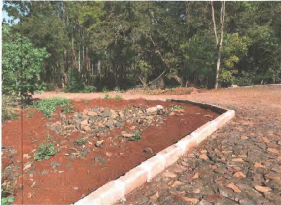
Foto 07 – Contenção inexistente e resíduos de obra por toda via
