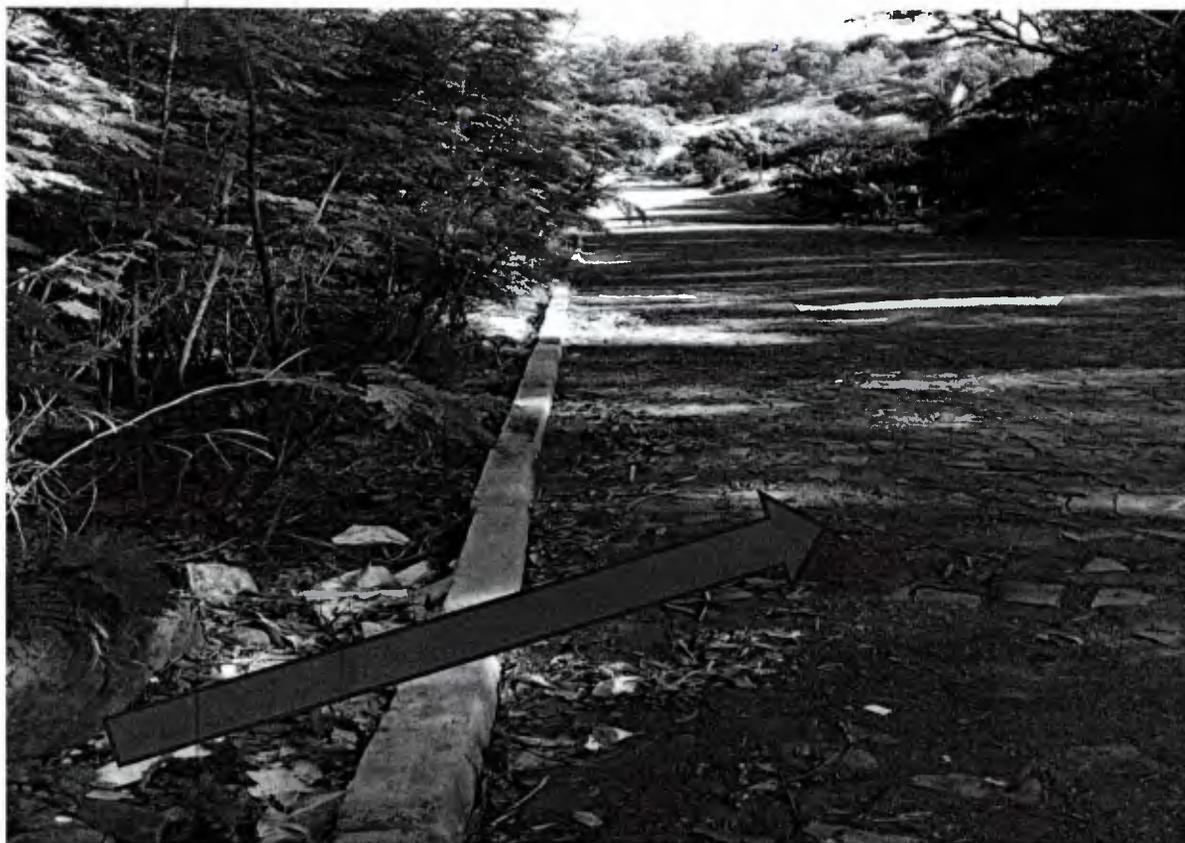
**Foto:08** Mostra após segunda compactação da primeira etapa a mais de seis meses mostrando as pedras firme e com rejunte bem firme entres as pedras e bem compactadas conforme projeto, essa foto também mostra lixo jogado por moradores na lateral.
