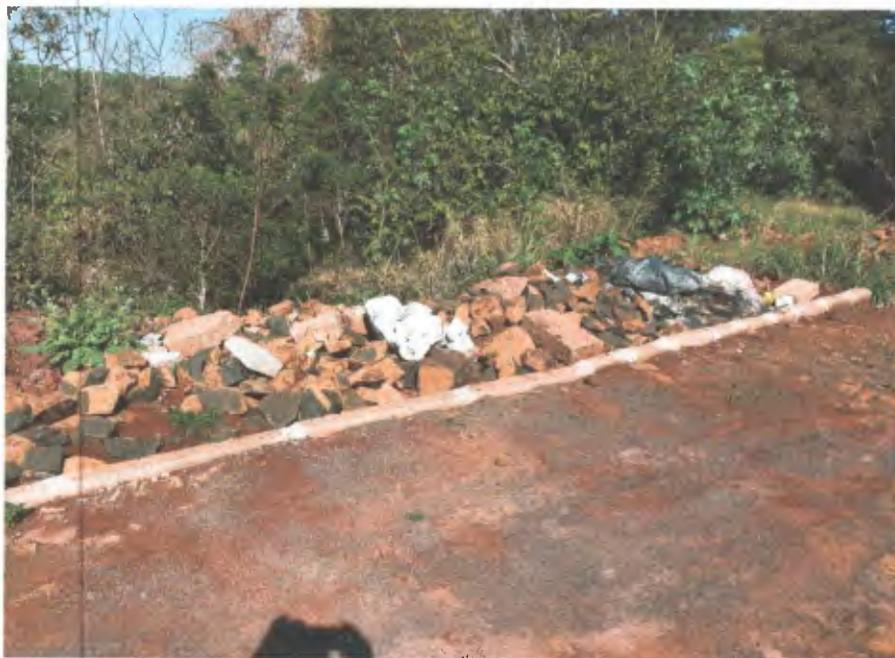
Foto 10 – Contenção inexistente e resíduos de obra por toda via
