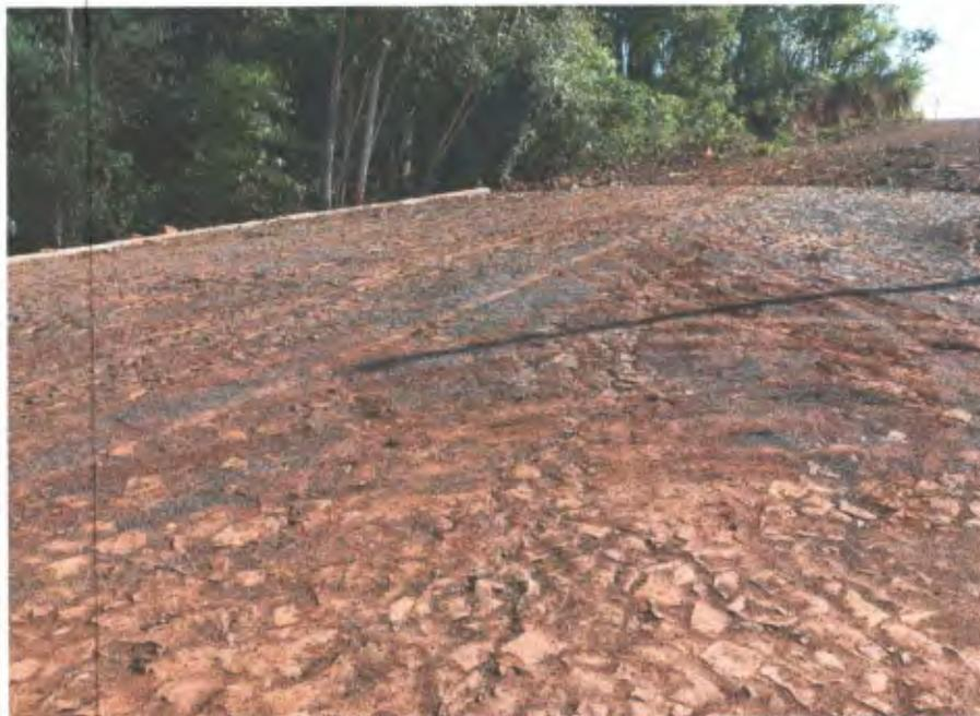
Foto 05 – Rejunte de pó de pedra insuficiente e incorreta execução
