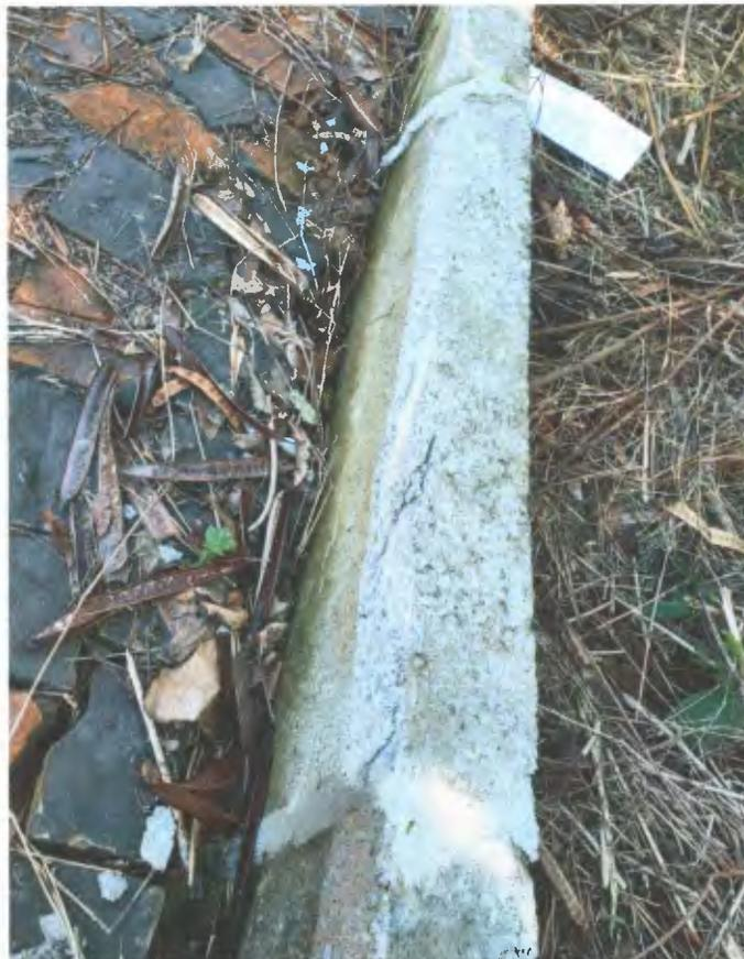
Foto 47 – Meio-fio cortado com aparentemente com serra circular elétrica
