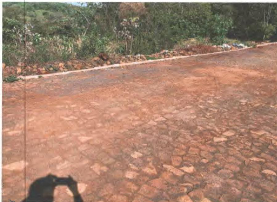
Foto 12 – Rejunte de pó de pedra insuficiente e incorreta execução
