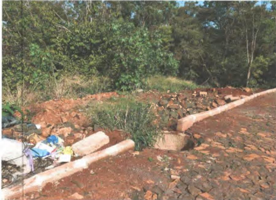
Foto 09 – Contenção inexistente e resíduos de obra por toda via
