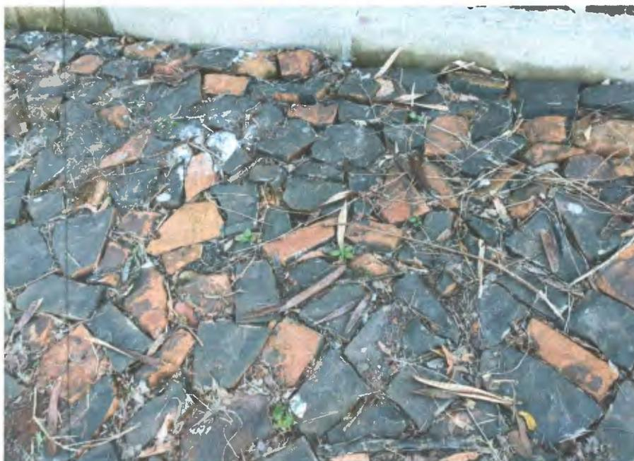
Foto 49 – Meio-fio cortado com aparentemente com serra circular elétrica e falta de rejunte
